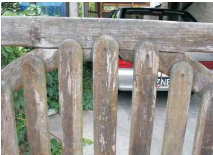
Ryc. 3. Ślady uszkodzeń dokonanych przez osy, widoczne na powierzchni zszarzałego drewna naturalnego. Fot. Bartłomiej Mazela
