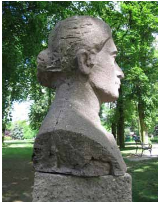
Ryc. 6. Popiersie Izabelli Ryxowej. Widoczne nieszczne łączenie technologiczne i korodujące zbrojenie pod cienką i porowatą otuliną betonową. Fot. Aleksandra Gralińska-Grubecka
