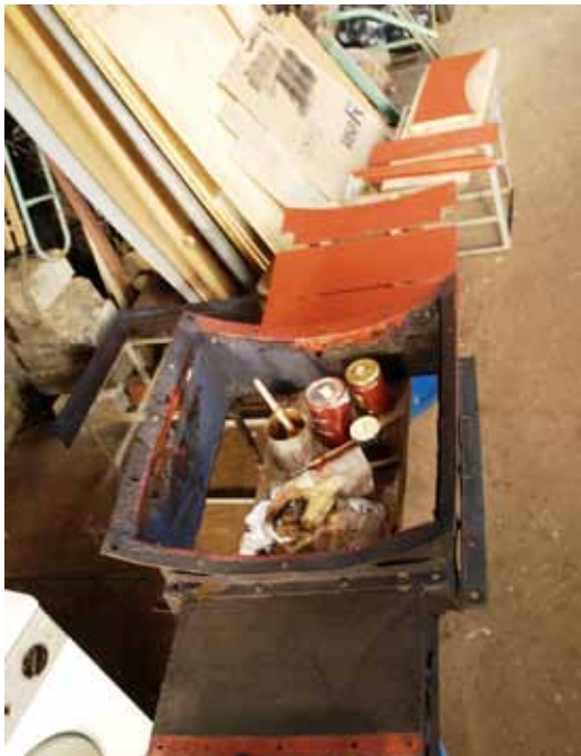
Ryc. 12. Krematorium, moduły łączące komin z korpusem po demontażu w trakcie wykonywania wzmocnienia. Fot. Marek Kołyшко
