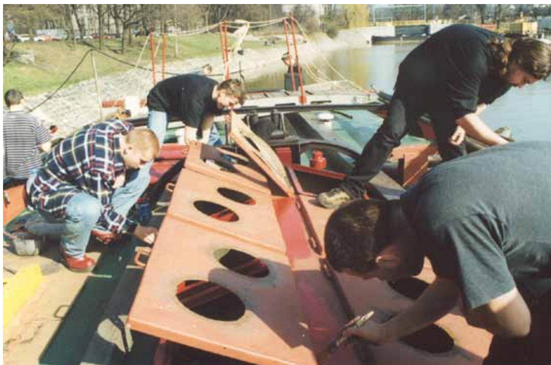
Ryc. 6. Odbudowa świetlików maszynowni HP „Nadbor”, 1999 rok. Fot. Stanisław Januszewski
