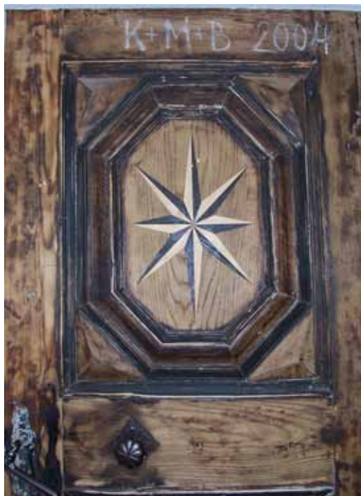
Ryc. 8. Barokowe klasztorne drzwi były pokryte wieloma warstwami farby z kolejnych odnowień. W dobrej wierze starano się oczyścić je z pomocą szlifierki. Wykonawca pracy na szczęście zorientował się, że przypala i niszczy delikatne zabytkowe intarsje, które ujawniły się pod spodem. Przerwał pracę i drzwi trafiły w ręce profesjonalnych konserwatorów, jednak oryginalne, subtelne opracowanie światłocieni intarsji zostało już nieodwracalnie utracone. Fot. Bogumiła J. Rouba
