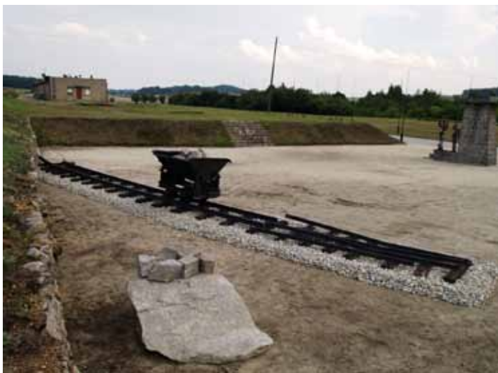
Ryc. 8. Wagonik z odcinkiem torowiska po pracach konserwatorskich. Fot. Marek Kołyszko
