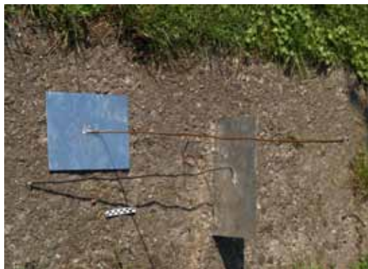
Ryc. 15. Protektory anodowe przed montażem. Fot. Marek Kołyszko
