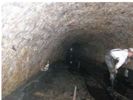
Widok Sztolni w rejonie mijanki w odległości 625 m od wylotu
