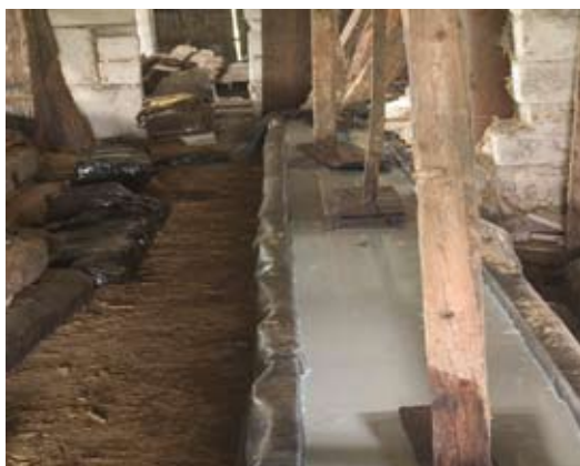
Ryc. 2a) basen impregnacyjny przeznaczony do nasycania drewna metodą moczenia podczas konserwacji – zabytkowe belki w trakcie nasycania roztworem żywicy. Obok widać belki nasycone roztworem żywicy, owinięte czarną folią w celu przedłużenia procesu dyfuzji
