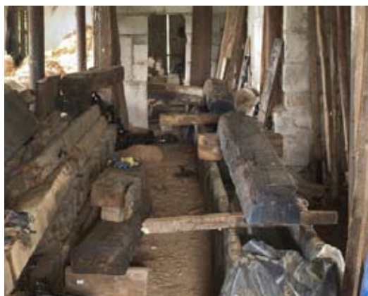
Ryc. 2b) basen impregnacyjny – zabytkowe belki po nasyceniu roztworem żywicy (fot. B. Biegowski)
