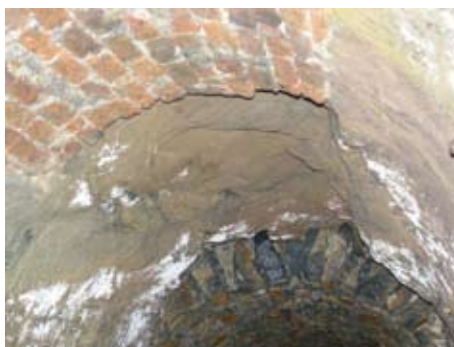
Fragment Sztolni o zróżnicowanej obudowie
