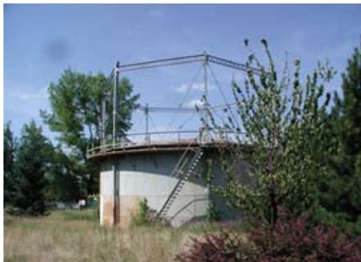
Gazownia w Sobótce – budynek administracyjno-produkcyjny i stalowy teleskopowy zbiornik gazu
